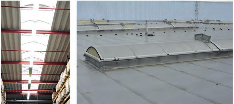
Bild 35: Oberlichtband zur Tageslichtversorgung des Regalgangs: Innenansicht (links), Außenansicht (rechts) [Quelle: daylighting.de].
