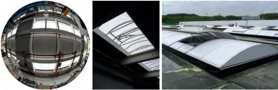
Bild 42: Mehrere Dachoberlichtbänder sorgen für eine Tageslichtversorgung der Produktionshalle (links). Innenansicht des Oberlichtes (mitte), Außenansicht (rechts) [Quelle: daylighting.de].
