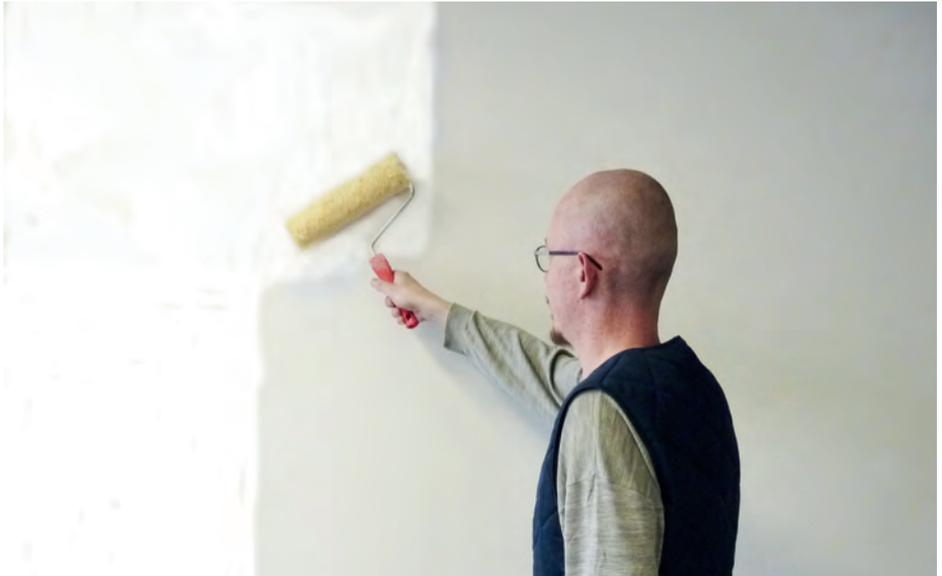
Bild 11: Eine Erneuerung der Anstriche mit heller Farbe kann die Beleuchtungsverhältnisse in Räumen erheblich verbessern [Quelle: Fraunhofer IBP].
