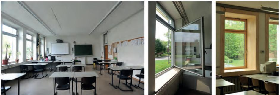
Bild 46: Klassenraum im Bestand (links) mit Bestandsfenster (mitte). Holzfenster der sanierten Fassade mit aufgrund der Wärmedämmung vergrößerter Laibungstiefe (rechts) [Quelle: daylighting.de].
