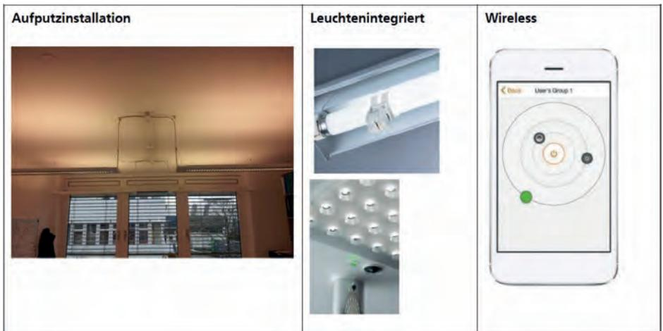
Bild 16: Nachrüstung von Lichtmanagement: Aufputzinstallation (links), leuchtenintegrierte Lösungen (mitte) und funkbasierte Technik (rechts) [Quellen: Fraunhofer IBP, Nimbus, Osram].
