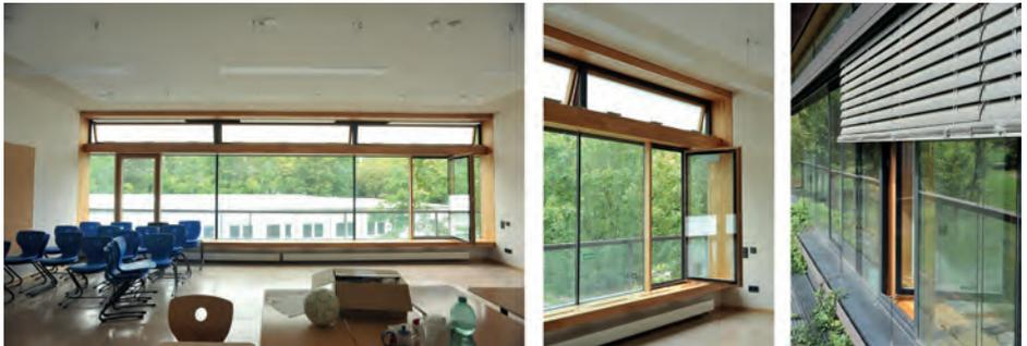
Bild 50: Große Fensterflächen ermöglichen eine gute Tageslichtversorgung (links). Lichtstreuendes Milchglas im oberen Bereich sorgt für eine Aufhellung der Decke in Fensternähe (mitte). Ein außen liegender Lamellenraffstore dient als Sonnenschutz (rechts) [Quelle: daylighting.de].
