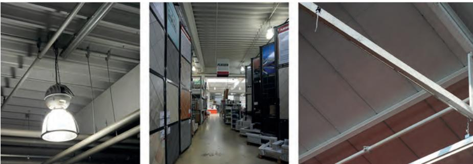
Bild 32: Die Bestandsleuchten (links) hatten insbesondere in Bereichen mit hohen Raumteilern (mitte) eine ungleichmäßige Beleuchtung zur Folge. Die neuen LED-Leuchten (rechts) lassen sich in Bezug auf die Gänge besser anordnen [Quelle: daylighting.de].
