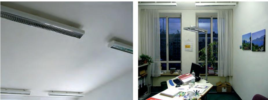
Bild 40: Die Bestandsleuchten (links) wurden durch LED-Stehleuchten ersetzt. Durch die korrekte Positionierung der LED-Stehleuchte mit indirekter Beleuchtung wird im Raum eine gleichmäßige Beleuchtung erreicht (rechts) [Quelle: S. Aydinli].
