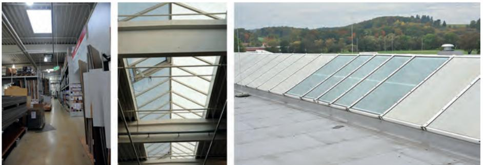
Bild 31: Einzelne Lichtkuppeln im Randbereich (links) reichen für die Tageslichtnutzung nicht aus. Das zentrale Oberlichtband (mitte) ist ausreichend dimensioniert, Abschnitte klarer Verglasung (rechts) ermöglichen Sonnenflecken im Innenraum [Quelle: daylighting.de].
