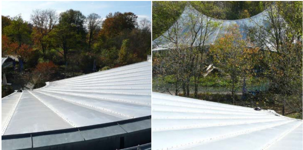
Bild 40: Dachkonstruktion des Schildkrötenhauses im Tierpark Hellabrunn [17].
