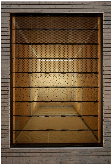
Abbildung 9.7: Exemplarische Schaltzustände einer TN-Verglasung mit vertikal gradier-tem Verlauf (links: Außenansicht) und zeitgesteuerter Sonnenstandsnachführung (rechts: Sequenz einzelner Innenansichten der Verglasung mit Verdunkelung im Bereich der Sonne)
