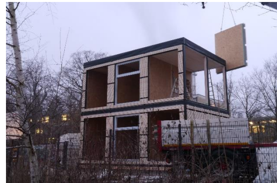
Abbildung 4.37: Unterschiedliche Montagezustände des modularen Fassadenprüfstands während der Errichtung
