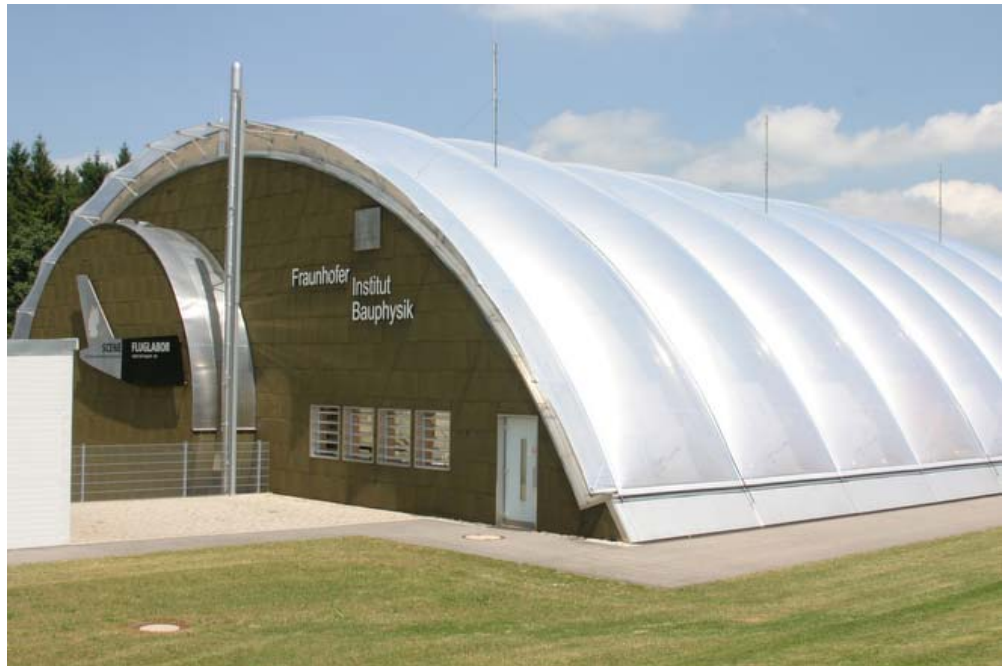
Bild 42: Flight-Test-Facility (FTF)-Halle des Fraunhofer-Instituts für Bauphysik IBP in Valley bei Holzkirchen.
