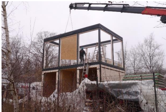
Abbildung 4.37: Unterschiedliche Montagezustände des modularen Fassadenprüfstands während der Errichtung
