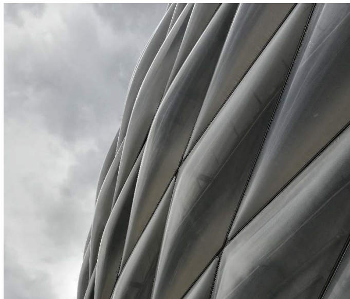
Bild 51: Pneumatisch vorgespannte Membrankonstruktion am Beispiel der Allianz-Arena in München [Quelle: Fraunhofer IBP]
