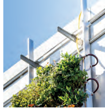
Abb. 85 Wasseranschluss über das Dach (IBP)
