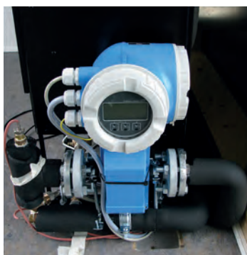
Abb. A15 Durchflussmessgerät, Vorlauf- / Rücklauf-temperatur (THN-AR)
