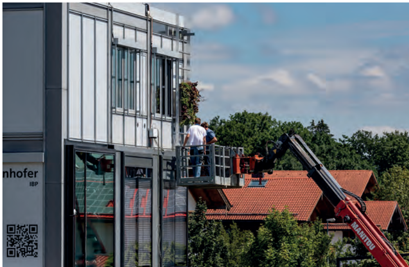
Abb. 78 Anbringen des Begrünungssystems von Verticalgreendesign (VGD) (07.08.2020) (IBP)
