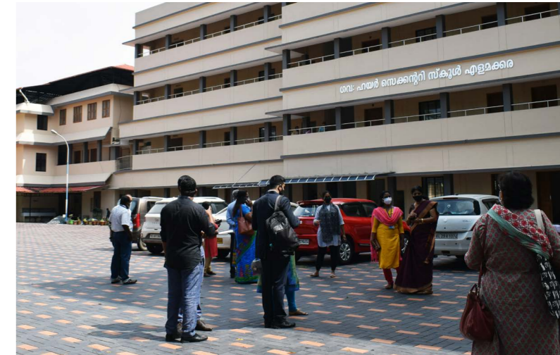
Gerade durch den hohen Versiegelungsgrad des Schulhofs können die geplanten Maßnahmen für ein spürbar besseres Mikroklima sorgen.
