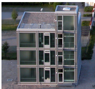
Bild 1: Nordansicht des VERU-Versuchsgebäudes
