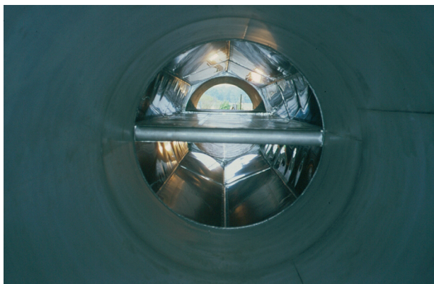
Bild 4: Foto des Eckigen Innenzuges mit Mittelkulisser.
