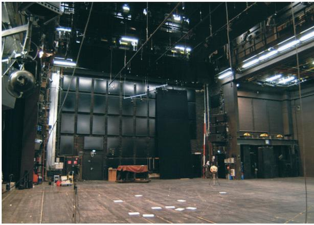
Bild 3: Tieffrequente Schall-Absorber im Bühnenturm.
