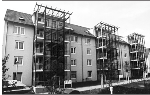
Bild 3: Nordansicht des Gebäudes mit den vorgesetzten Treppenhäusern.
