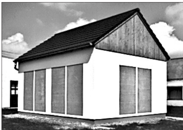
Bild 1: Photographische Aufnahme des Versuchsgebäudes, welches auf dem Freilandversuchsgelände des Fraunhofer-Instituts für Bauphysik in Holzkirchen steht.
