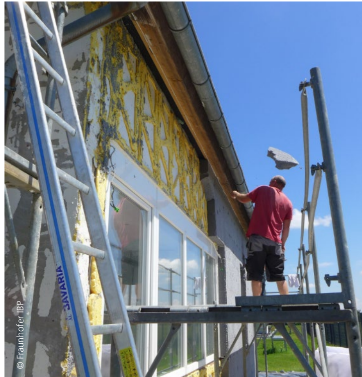
Abschälen des Dämmstoffs
