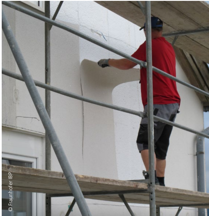
Strippen der Putzschicht
