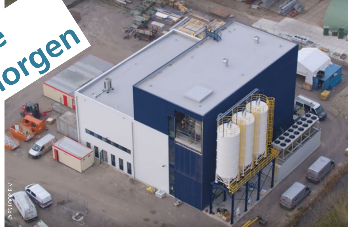
PolyStyreneLoop Anlage in Terneuzen, NL
