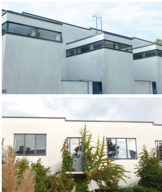
Bild 1 Fotografische Aufnahmen des Reihenhauses im heutigen Zustand, a) Eingangsseite auf der Nordseite, b) Details mit Fenster und einem Balkon auf der Südseite Photograph of the house (E. Veres) in its present condition, a) entrance side on the north side, b) details with window and a balcony on the south side
