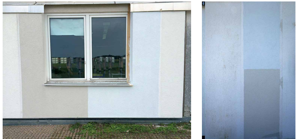
Abb. 9: Westfassade (Foto links) mit beige-grauer (links) und blau-grauer (rechts) IR-Beschichtung sowie Nordfassade (Foto rechts) mit den Beschichtungen übereinander
