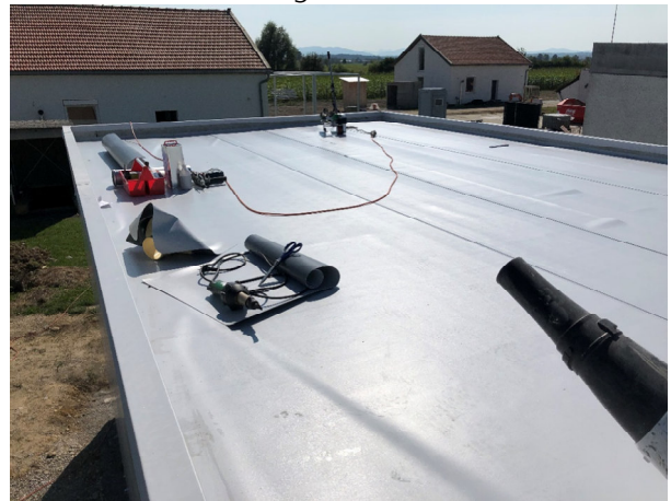
Dachabdichtung vor dem Aufbringen von Kies
