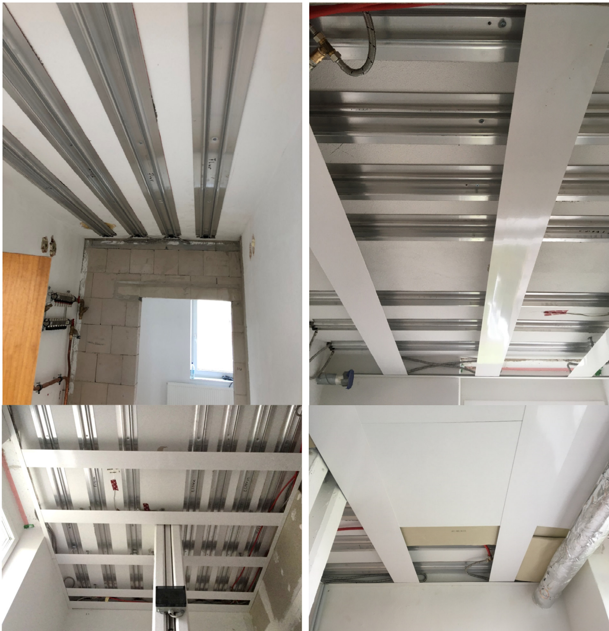
Bild 101: Aufbau des BTA-Speichers für Sanierungs-Decken im BTA-Zwillingshaus.
