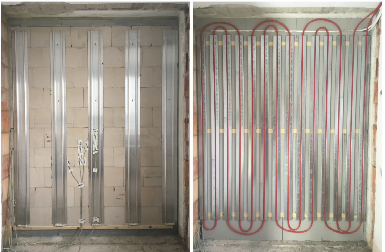
Bild 82: Sanierungs-Wand während des Aufbaus im N2-Zwillingshaus des Fraunhofer IBP: Links: Lamellen zur Be- und Entladung des BTA-Speicher (ohne Verrohrung). Rechts: System der aktiven Entladung (KlimaSan) vor Montage der Trockenbauverschalung.
