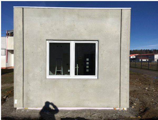
Außenansicht des fertigen CUBES
