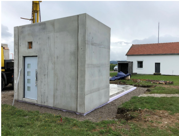
Während des Aufbaus; Bodenplatte und Technikraum aufgestellt
