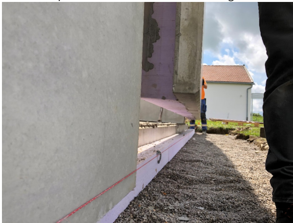
Setzen der Westwand des Messraums
