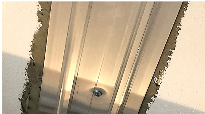
Bild 19: Darstellung des Wärmeleitprofils „Raum-K Buffer“ zur thermischen Aktivierung von Bauteilmassen als BTA-Speicher.
