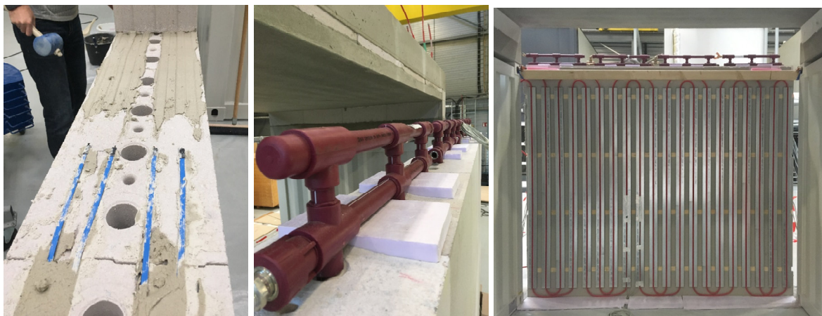
Bild 77: Neubau-Wand (Kalksandstein) während des Aufbaus im Technikum: Links: Sensoren zur Ermittlung der Temperaturverteilung über den Wandquerschnitt (siehe Bild 76). Mitte: Eingebrachtes KS-XK-Wandtemperierungssystem. Rechts: Ansicht des Systems zur aktiven Entladung (KlimaSan), ohne Trockenbauabschluss.
