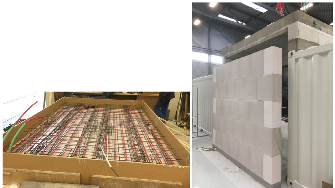
Bild 74: Links: Neubau-Decke während des Sensoreinbaus vor dem Betonieren im Fertigteilwerk von Concrete Rudolph. Rechts: Neubau-Decke auf und Neubau-Wand vor den Übersee-Containern im Technikum des Fraunhofer IBP.
