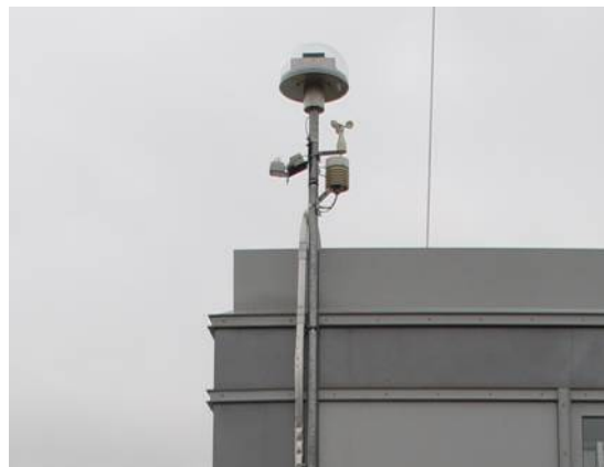
Bild 11: Tageslichtmesskopf am Dach des VERU-Gebäudes.
