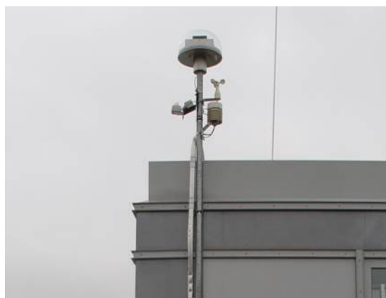
Bild 11: Tageslichtmesskopf am Dach des VERU-Gebäudes.
