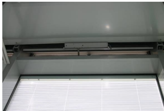
Bild 15: Innenansicht einer geöffneten Lüftungsklappe der Glasdoppelfassade.
