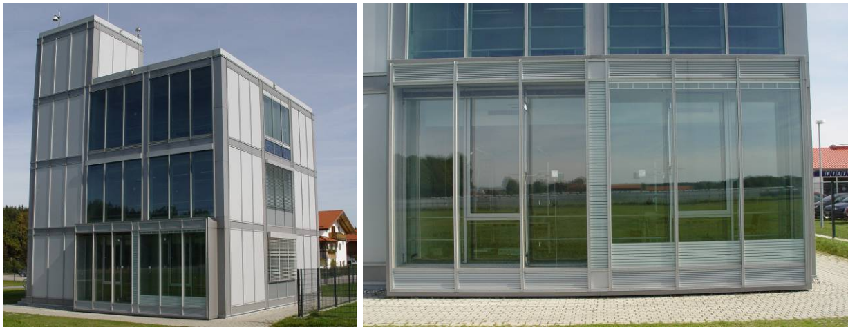
Bild 2: Außenansichten von Südwest bzw. West der am VERU-Versuchsgebäude realisierten Doppelfassaden.
