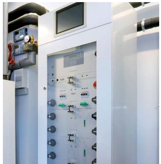
Batteriespeicher, 13,2 Kilowattstunden
