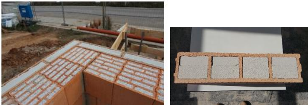
Abbildung 3: Zweischalige Bauweise mit 30 cm dicken Perlit-gefüllten Mauerziegeln und 12 cm dicken CALOSTAT-gefüllten WDF 12 Vorsatzziegeln (links) und CALOSTAT-gefüllter WDF 12-Ausgleichsziegel (rechts)
