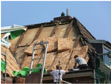
Abbildung 78: Dachsanierung eines Altbaus mit Zwischen- und Aufsparrendämmung [33]
