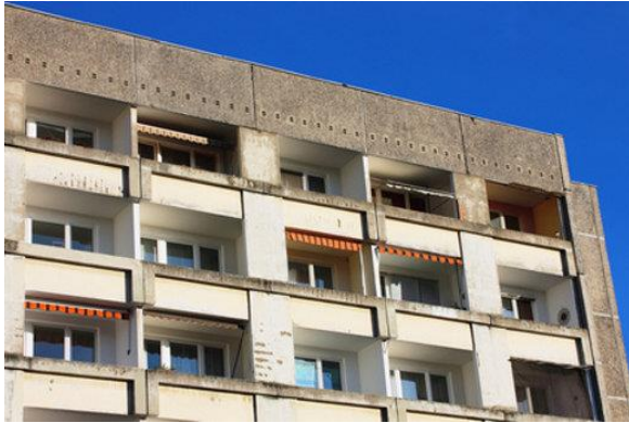
Abbildung 72: Plattenbau aus den 1970er Jahren [27]
