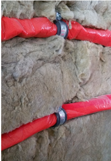
Passgenaue Rohrbefestigungen für Trinkwasser-, Abwasser- und Lüftungsleitungen
