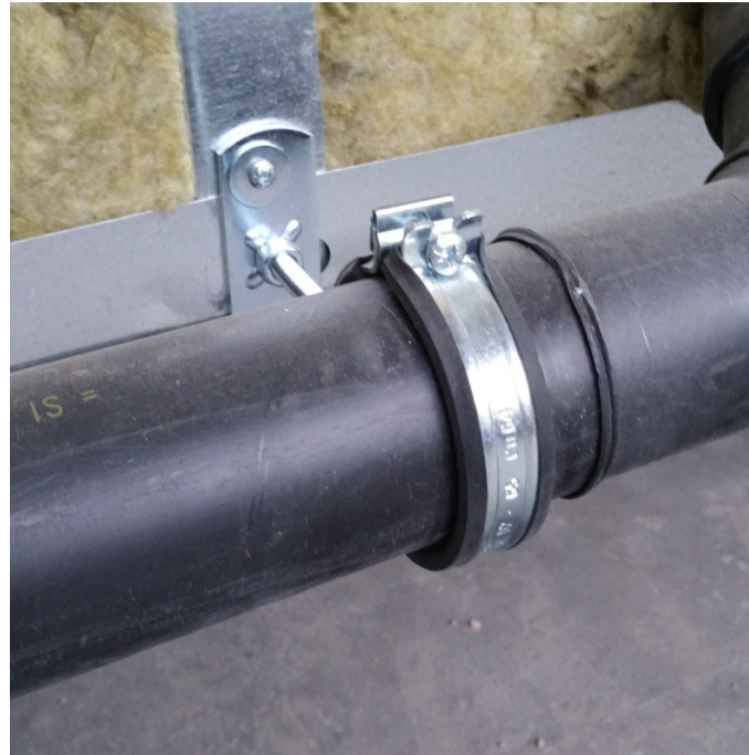
Passgenaue Rohrbefestigungen für Trinkwasser-, Abwasser- und Lüftungsleitungen
