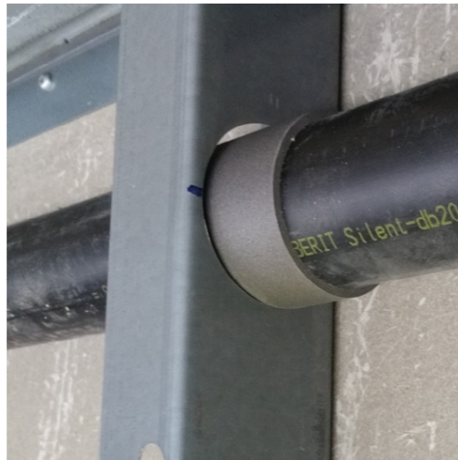
Rohrführung durch Wandprofil
