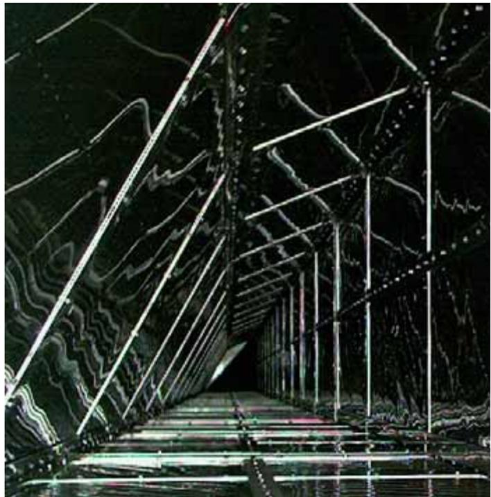
Eckiger Innenzug als integrierter Schalldämpfer in einem Stahlschornstein
