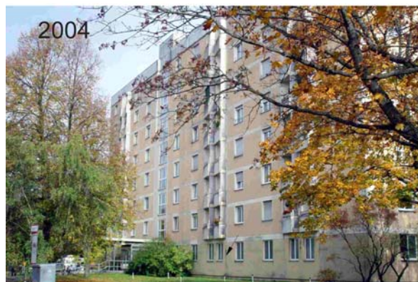
Figure1. ミュンヘンの建物Nr.16の西面。複合外断熱システムの施工後、4年後(1989)および19年後(2004)の様子。この間に改修は行われていない(写真の色調が異なるのはカメラの性能による)。この断熱システムは技術的な欠陥なしに機能している。
