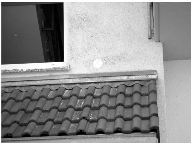
Bild 1: Teilansicht der Nordfassade und der Probenentnahmestelle mit sichtbarem Algen- und Schimmelpilzbewuchs.
