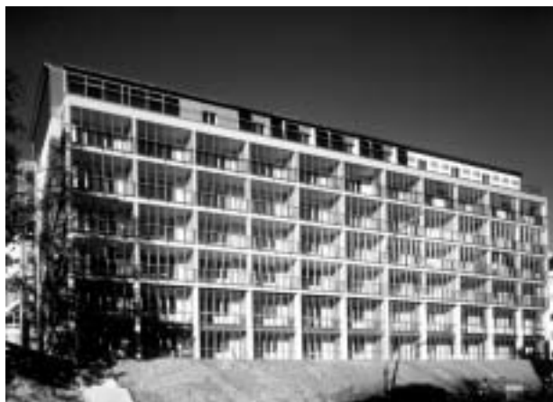
Bild 1: Südansicht des Mehrfamilienhauses.
