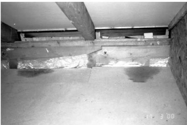
Bild 4: Fotografische Aufnahme der Feuchteflecken durch den am 17. März 2000 bei Variante 1 eingetragenen Flugschnee auf der Oberseite der mit Spanplatten beplankten Decke.
