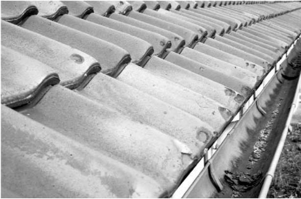
Bild 2: Typische Frostschäden an engobierten Tondachziegeln (Freigelände Holzkirchen).
