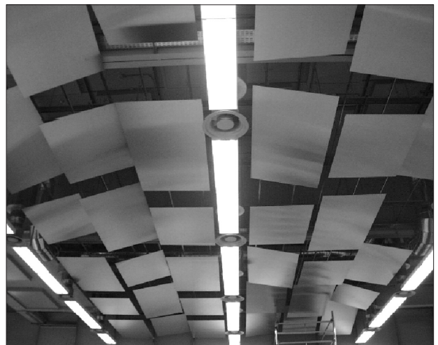
Bild 2: Aufnahme der Reflektoren und der VPR-Module unter der Decke nach dem Umbau.
