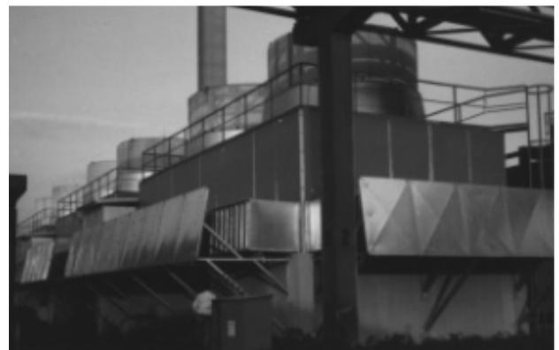
Bild 1: Die Rückkühlwerke nach ihrer schalltechnischen Sanierung
