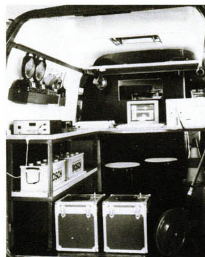
Bild 2: Fotografische Aufnahme (Innenansicht) eines Meßwagens, der für die Leckortung neu ausgerüstet wurde. (Foto: Energieversorgung Oberhausen AG)
