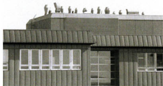
Bild 1: Typische Anordnung von Lüftungseinrichtungen auf Industriedächern
